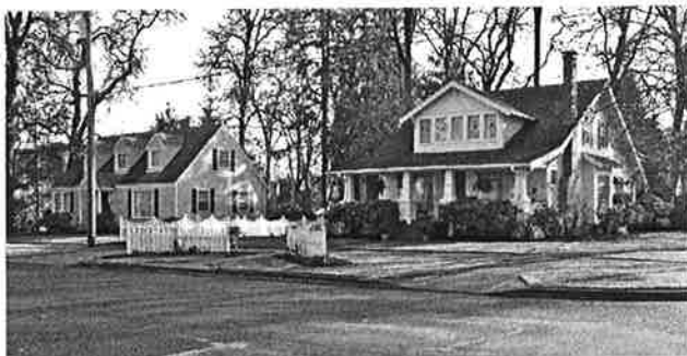
15.) 2204, 2212 15 th Ave, facing SE
