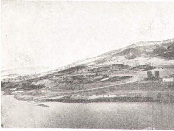
DERİVASYON TÜNELLERİ — İnşaatı şantiyesinin karşı sahilinden görünüşü
