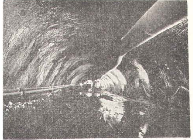
DERİVASYON TÜNELİ — Üst yarı hafriyatı ve desteklenmiş kesit
