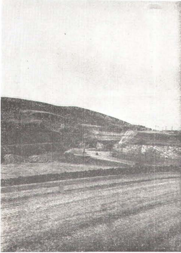
DERİVASYON TÜNELİ — Giriş ağızları hafriyatı
