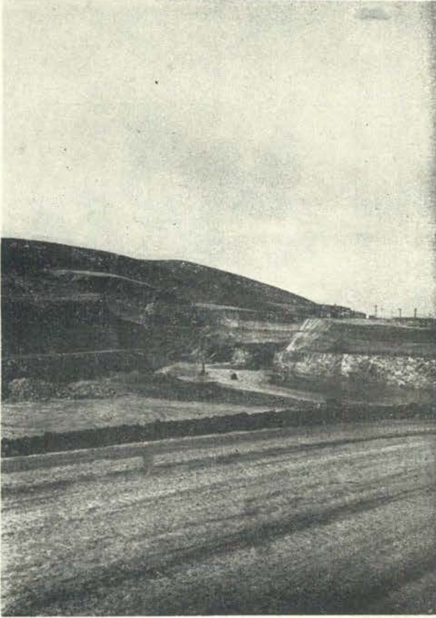
DERİVASYON TÜNELİ — Giriş ağızları hafriyatı
