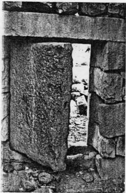
Abb. 154. Basaltplatte als Hauseingangstür; Umm el Djemal in Nordostjordanien Fig. 154. Basalt slab used as entrance door; Umm el Djemal in Northeast-Jordan
