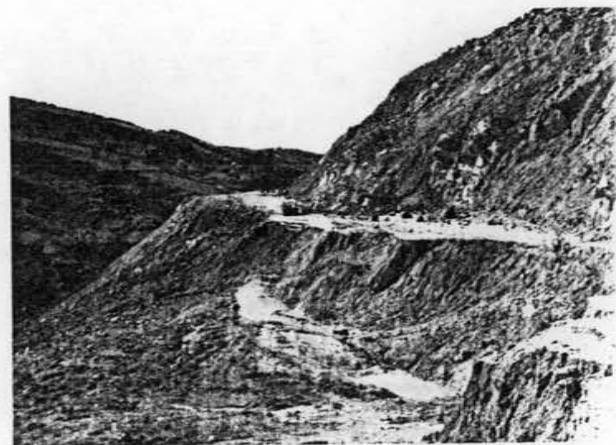
Abb. 102. Absenkung der Hauptstraße Amman–Jerusalem (bei Naur) um 7 m im 1963/64; Grenzschichten bunte Sandsteine der Unterkreide/Knauernkalke des Cenoman
